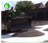
6 plaatsen van het grind
